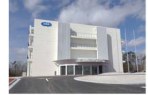
大熊分析・研究センター施設管理棟
