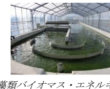
藻類バイオマス・エネルギー実証施設
